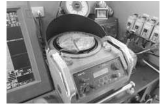
自動操舵機 （オートパイロット）
