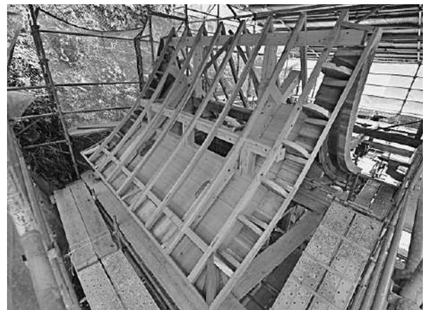
檜皮葺きの屋根の形に下地を整えた（本殿）
