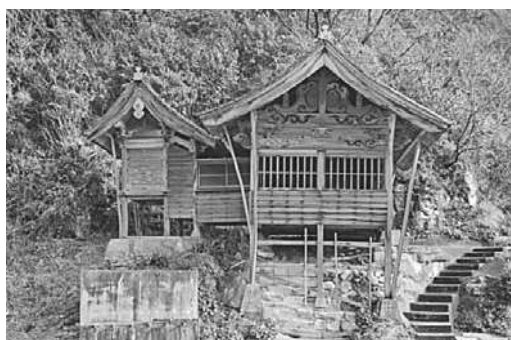
修理前の社殿
