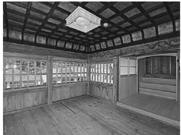
修理後の拝殿内部の様子（拝殿）
