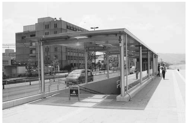
第15回 大賞 嫁島地下道上屋（宍道湖夕日スポット）
