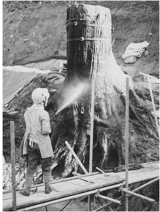
埋没スギ（根株）の発掘作業中（1999年）
