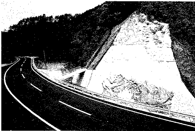
島根県出雲農林振興センター優良工事（大邑地区広域農道整備工事）
