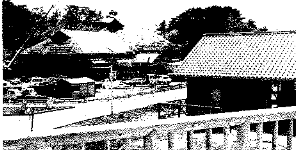
「急ピッチで進む自然館建設工事」（森林公園木橋より望む）
