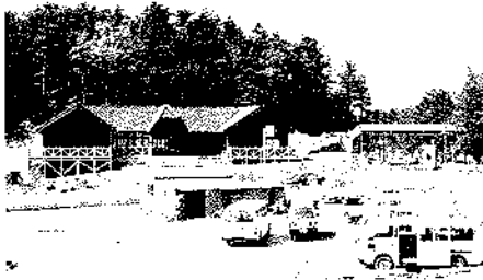
「姿を現わした管理棟と木橋」
